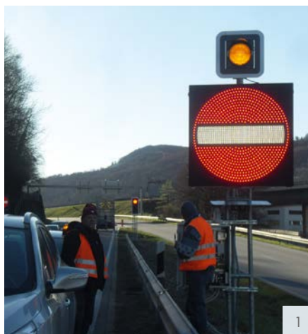
Image 1: 1 er élément – installation et test du panneau LED avec feu clignotant équipé de capteurs
